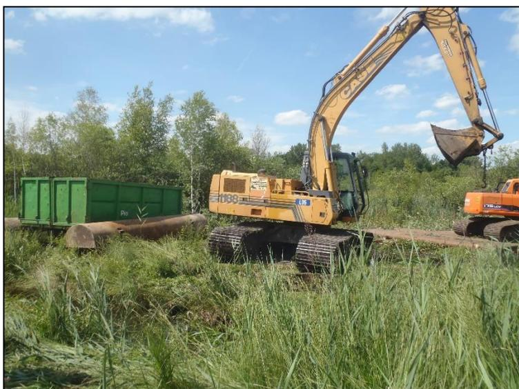
Exemple d'opération de déboisement par essouchage mécanisé. Les engins travaillent sur de grandes plaques pour ne pas tasser la tourbe.
