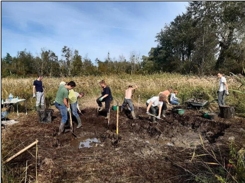
Exemple de création de mares en périphérie d'un marais tourbeux. Recouverte par des alluvions, la tourbe apparait ici vers 80 cm. la profondeur de la mare correspond globalement à la profondeur d'apparition de la tourbe.
