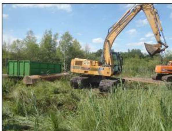
Exemple d'opération de déboisement par essouchage mécanisé. Les engins travaillent sur de grandes plaques pour ne pas tasser la tourbe.
