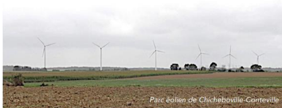
Parc éolien de Chicheboville-Conteville (©Agence Schneider)
